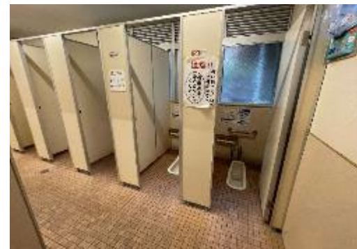
女子トイレ現状（和式あり）
