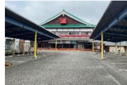
劇場東面・駐車場棟
