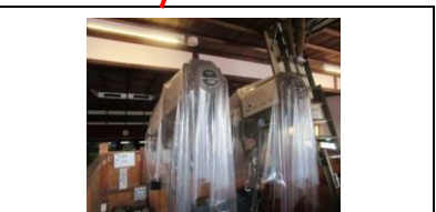
ピンスポットライトの角度が緩く、舞台上を照射するにあたり適切でない
