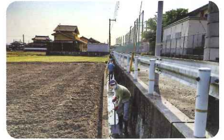
用排水路清掃作業
