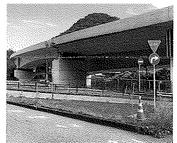
完成した八木山バイパス 篠栗側(山手)高架橋
