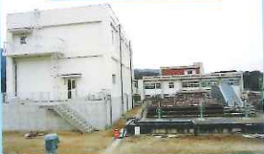
明星寺浄水場
