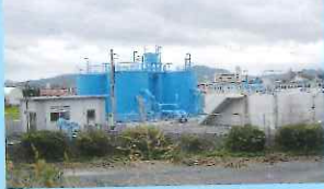
堀池浄水場(水源発祥の井)
