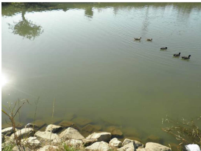
太郎丸樋管の様子
