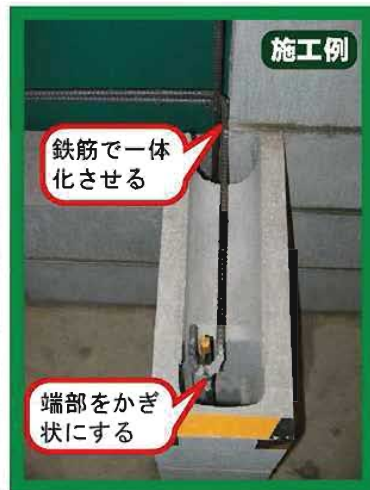
塀と一体に施工されていないため、控壁には径9mm以上の鉄筋を配置し、ブロック塀と一体となるよう施工する 地震で損傷を受け、役目を果たせなかった控壁
