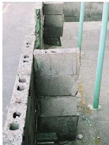
塀と一体に施工されていないため、控壁には径9mm以上の鉄筋を配置し、ブロック塀と一体となるよう施工する 地震で損傷を受け、役目を果たせなかった控壁
