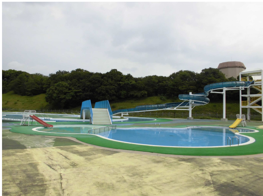
屋外レジャープール
