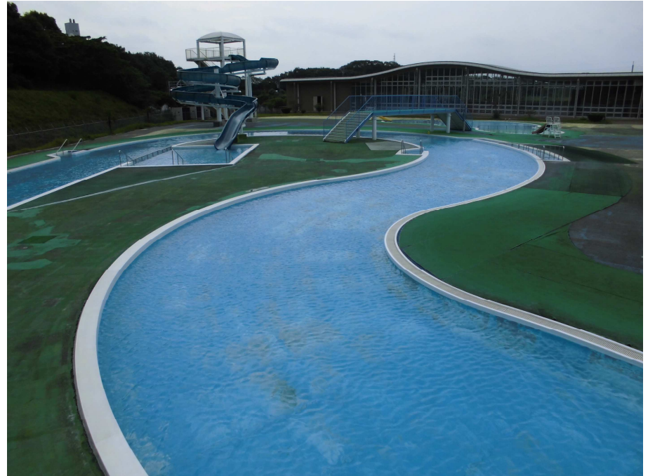
屋外レジャープール
