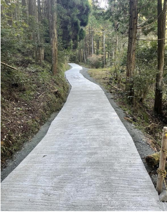
写真⑤ 整備した林内作業道
