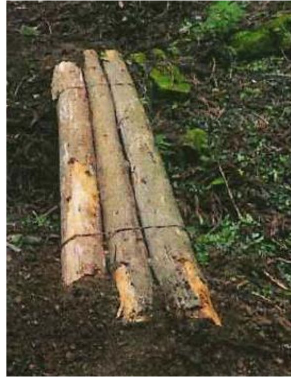
写真⑥ 八木山溪流公園内丸太橋
