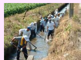
水路の泥上げ
