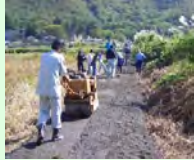
未舗装農道の舗装
