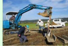
コンクリート水路の更新
