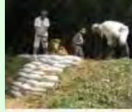
漏水箇所の補修
