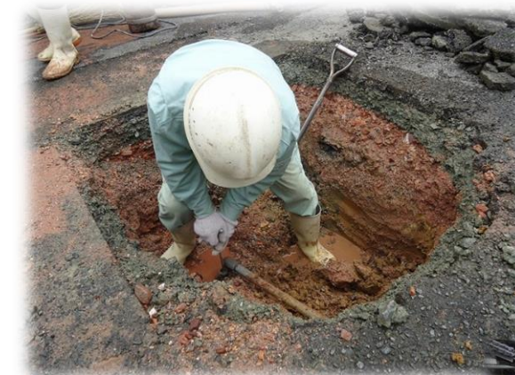
管渠埋設作業風景
