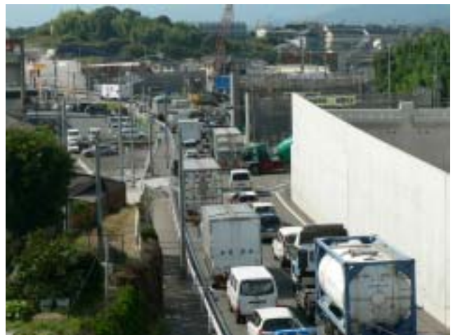
渋滞が発生しやすい交差点の改良工事（片島地区）
