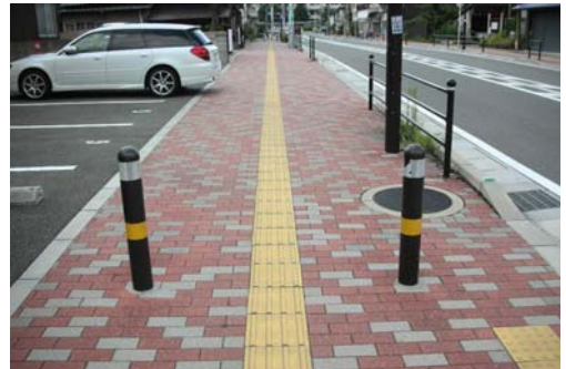
バリアフリー化された歩道
