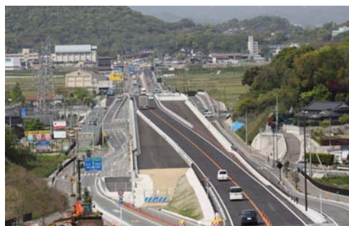
国道 201 号飯塚庄内田川バイパス
