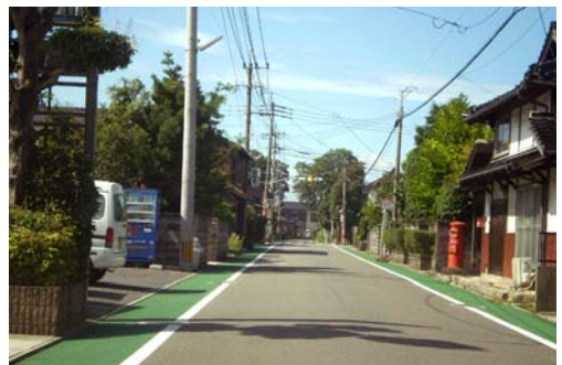
カラー舗装による歩車分離
