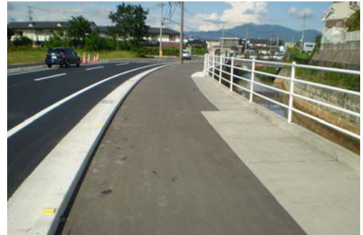
拡幅された歩道
