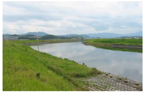
遠賀川（一本木井堰付近）
