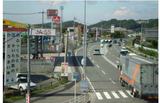
国道 200 号バイパス沿道
