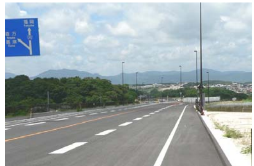
国道201号飯塚庄内田川バイパス
