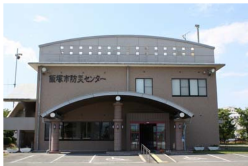
防災センター
